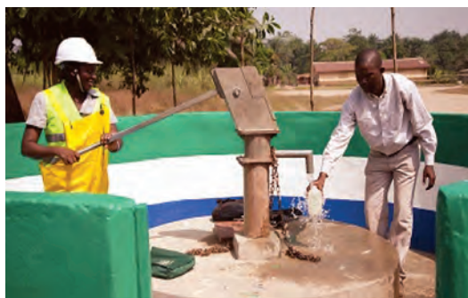
Installation de la pompe à eau
